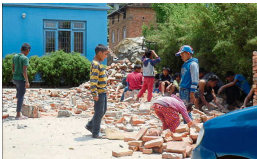
Alle halfen zusammen, den Mörtel von den Ziegeln abzuklopfen. Damit soll die eingestürzte Mauer wieder aufgebaut werden.
