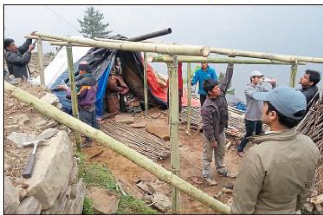
Hütten werden provisorisch wieder aufgebaut.
