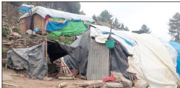
Einem Sturm vor drei Wochen hielten viele solcher Behelfshütten nicht stand.
